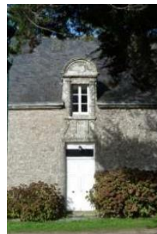
Détail de la façade du château de Tuloc
