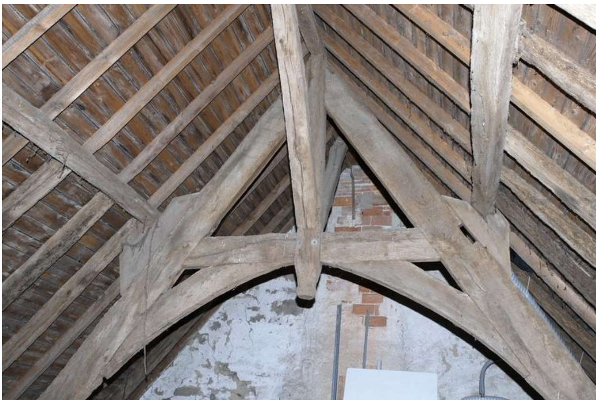
Guérande, manoir de Kerpondarmesn charpente
