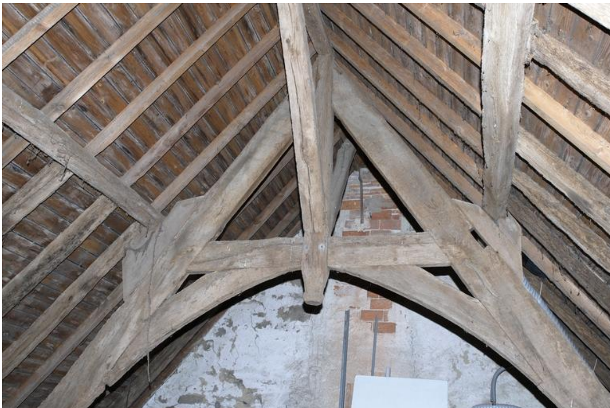
Guérande, manoir de Kerpondarmes charpente
